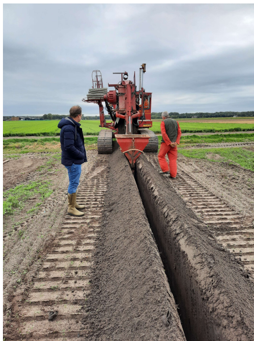
Figuur 2-4: Aanleg ijzerzanddrain.
