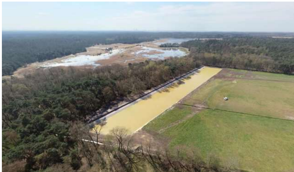
Figuur 0-2: IJzerzandfilter bij Grootte Meer in Brabant.
